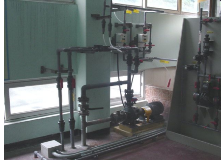
<그림 5.3.10> 황산주입설비 이젝터 및 희석수펌프
