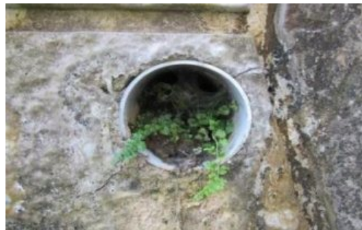
〈그림 3-65〉 배수공 불량 상태
