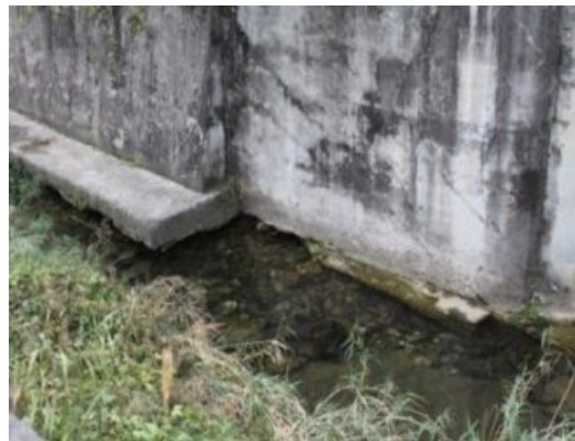
〈그림 6-36〉 세굴 발생 깊이 모식도 및 세굴 현상 예시
