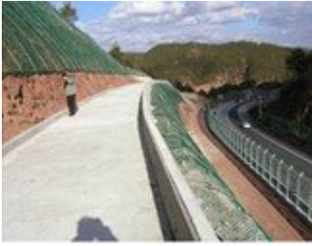
소단배수로 시공 양호
