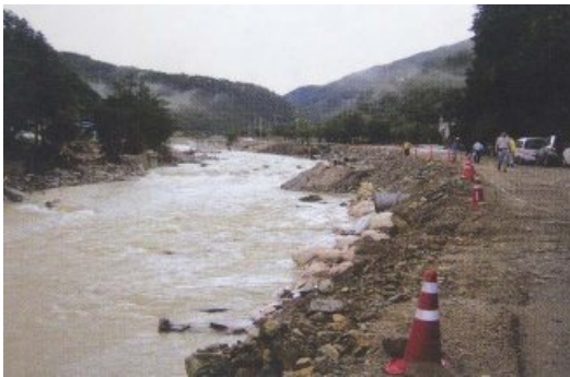
〈그림 3-114〉 수위상승에 의한 성토부 지반의 침식 및 세굴
