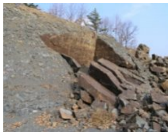
〈그림 4-21〉 지질구조에 의한 내측방향 발달 절리 형태
