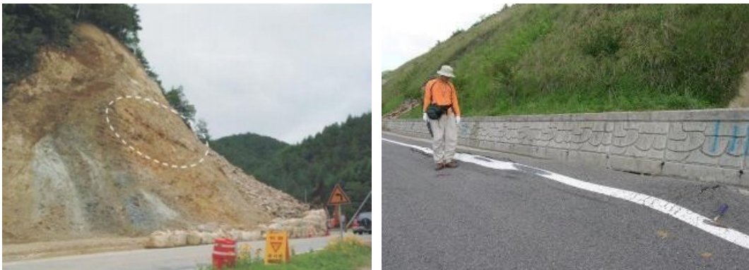
〈그림 3-42〉 배부름 및 하단부 지반 융기
