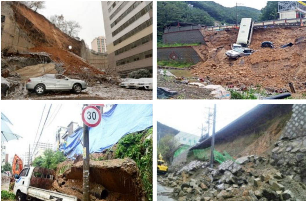
〈그림 9-12〉 옹벽, 석축의 붕괴사례
