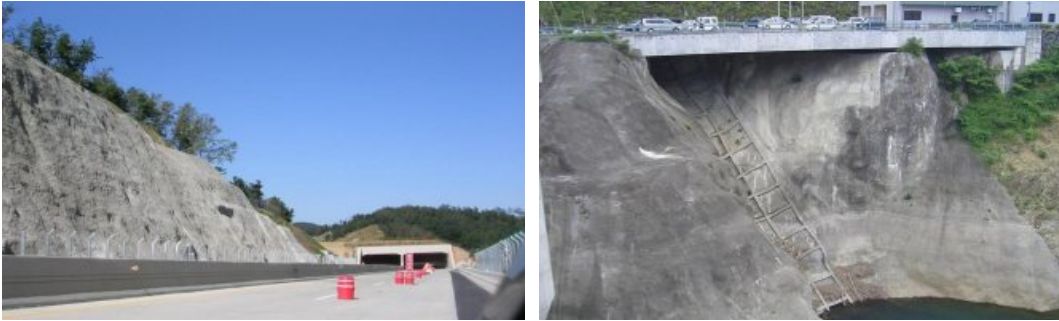
(사진 8-8) 콘크리트 뿔어붙이기
