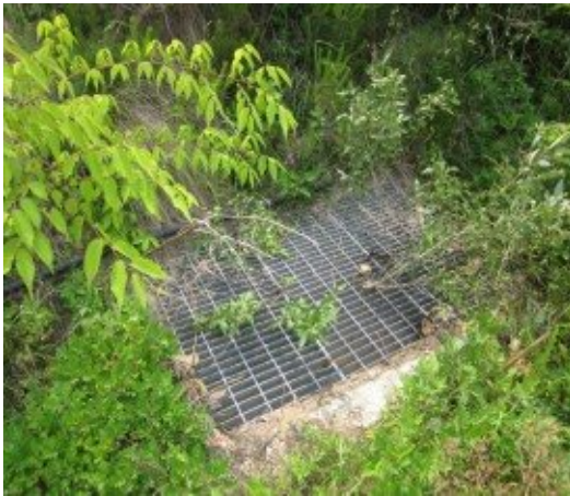
〈그림 3-150〉 집수정 설치 상태
