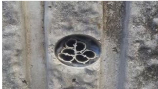
배수구 추가 설치 후
