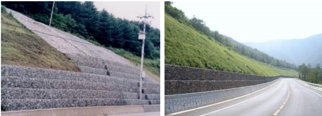
(사진 8-20) 돌망태 옹벽
