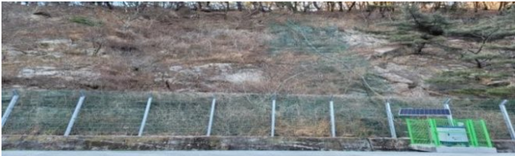
센서 설치 전경
