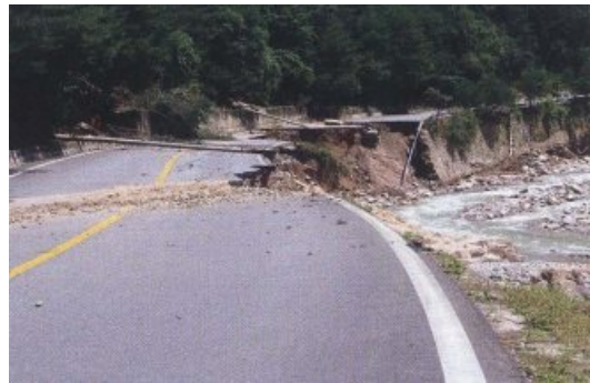
〈그림 3-114〉 수위상승에 의한 성토부 지반의 침식 및 세굴
