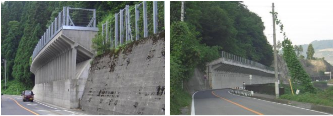
(사진 8-25) 낙석방지 옹벽
