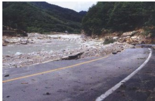
〈그림 3-115〉 하천수충부에서의 도로 및 쌓기비탈면 유실 사례
