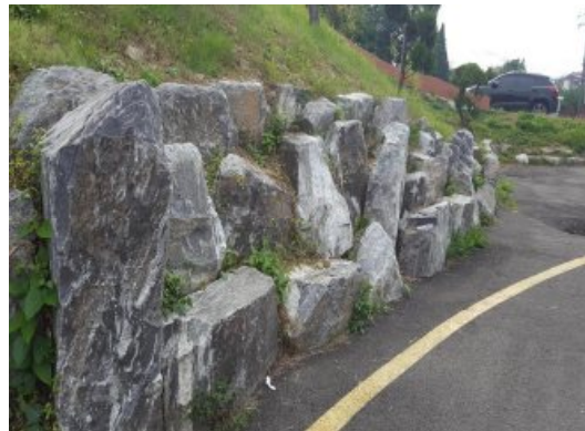
(사진 8-4) 돌쌓기(석축) 옹벽(메쌓기)
