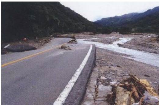
〈그림 3-115〉 하천수충부에서의 도로 및 쌓기비탈면 유실 사례
