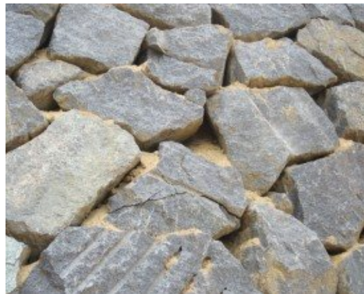
〈그림 3-147〉 이완 및 토사 유실
