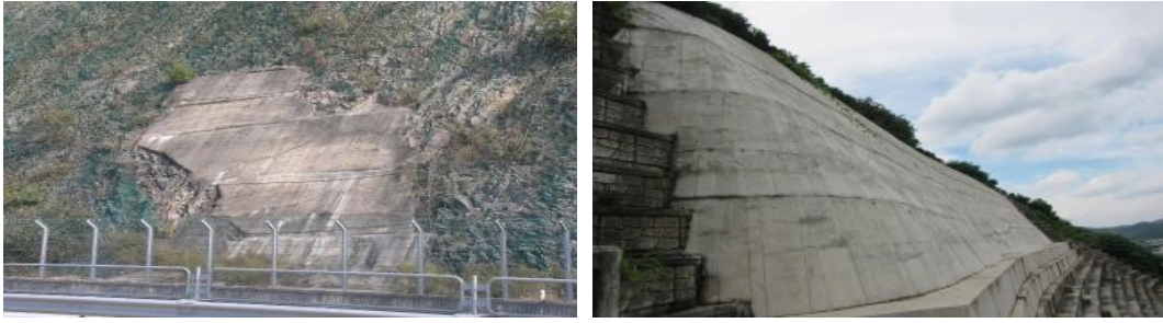
(사진 8-14) 콘크리트 버팀벽(buttrass)
