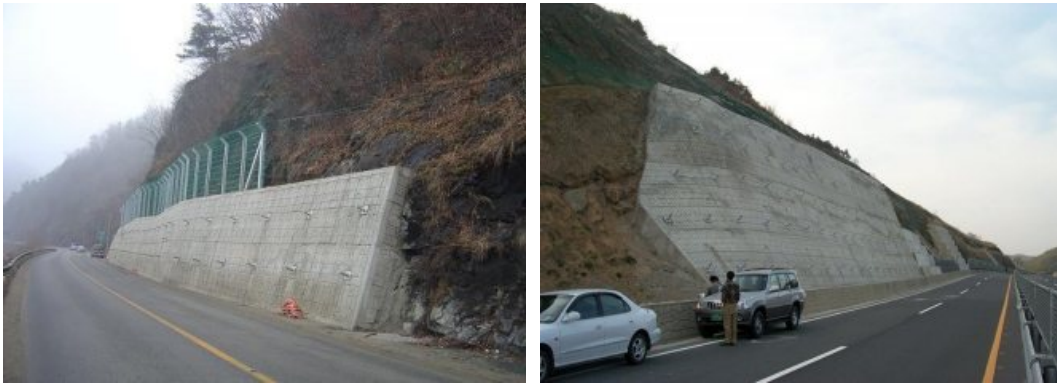
(사진 8-15) 합벽식 옹벽
