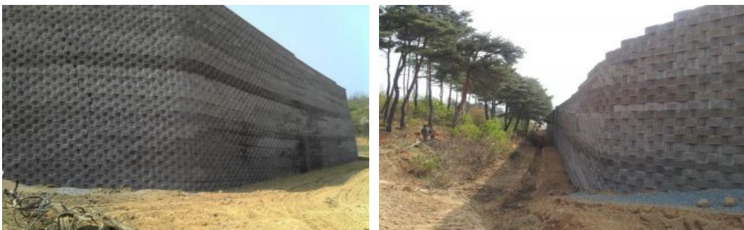
(사진 8-19) 보강토 옹벽
