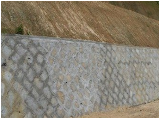
(사진 8-3) 돌쌓기(석축) 옹벽(찰쌓기)
