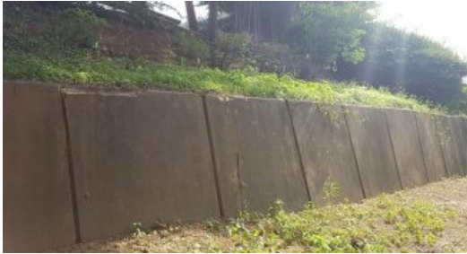
(사진 8-17) 콘크리트 옹벽
