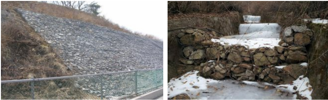
(사진 8-9) 매트리스 게비온(Mattress Gabion)
