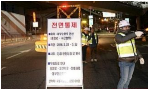
도로통제(안내입간판 및 신호수)
