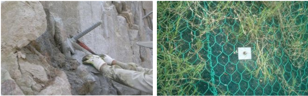
(사진 8-10) 록볼트(Rock bolt)
