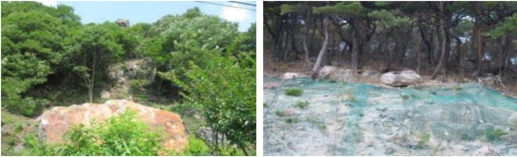
〈그림 3-93〉 상부자연비탈면에 존재하는 낙석위험블록
