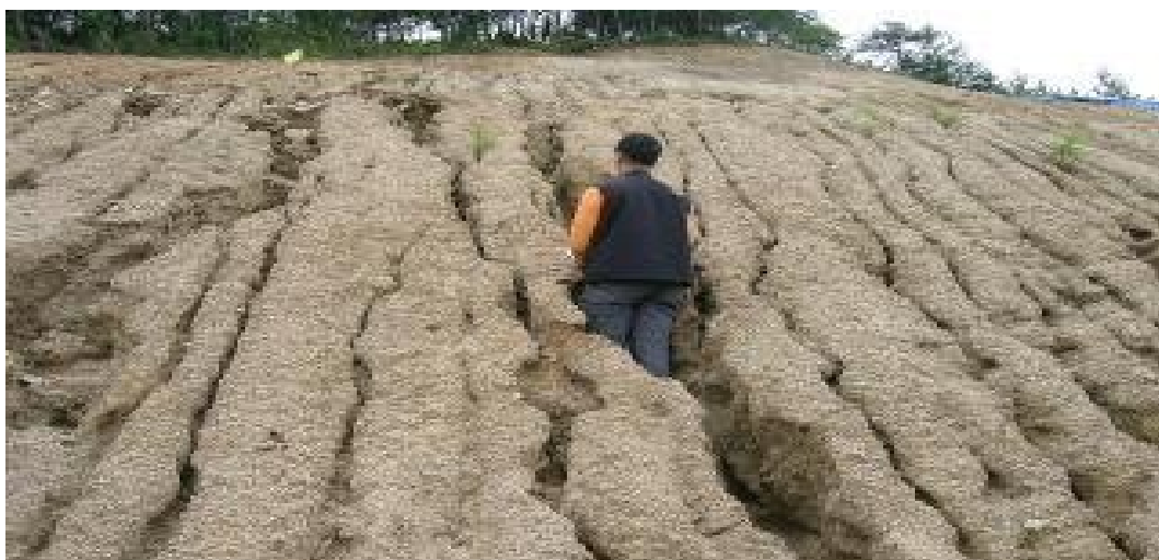
〈그림 3-23〉 화강풍화토 비탈면의 침식 및 세굴 현상
