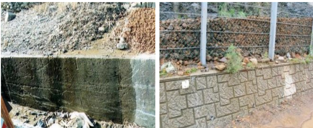
〈그림 9-55〉 붕괴 비탈면의 급격한 지하수 용출
