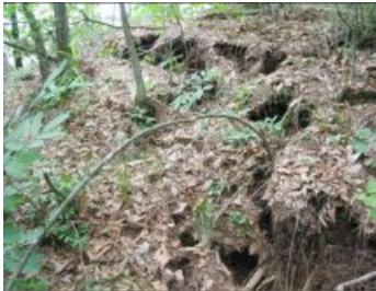
상부자연비탈면 내 인장균열
