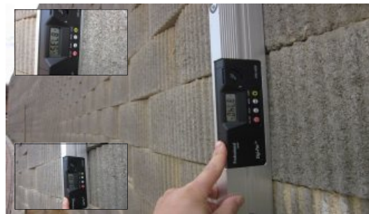
〈그림 3-139〉 수직도 측정(87.40°)
