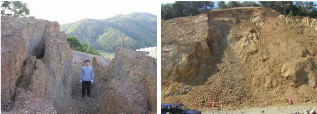
〈그림 3-32〉 단층에 의한 붕괴 발생 사례
