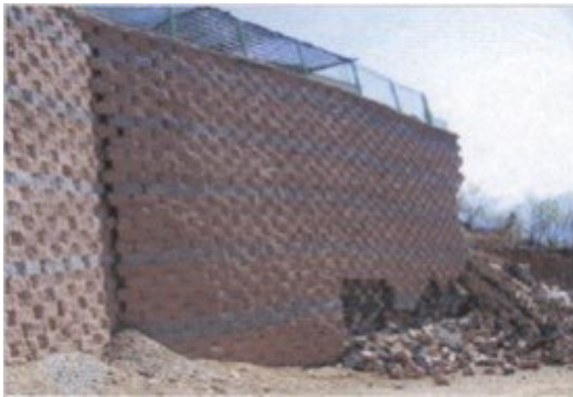
〈그림 3-73〉 전면판의 유실
