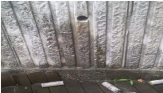
배수구 추가 설치 중
