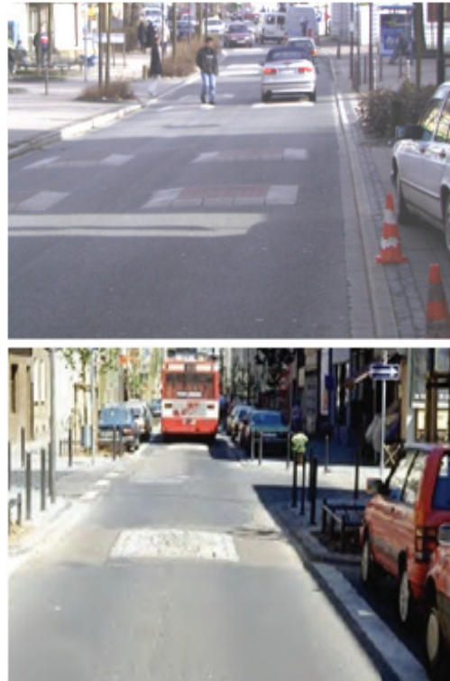
〈그림 3-31〉 소형 과속방지턱 설계 기준 및 설치 사례 (Pfundt, Meewes, 1986)
