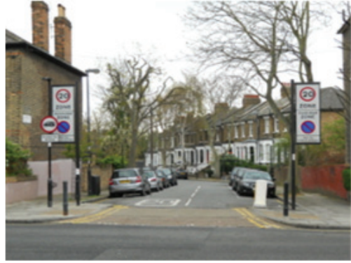
〈그림 3-48〉 주거지역 진입부 고원식 험프 설치 개념도 및 사례 (Richard, Steven, 2000)
