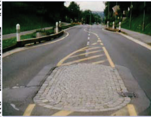
〈그림 3-54〉 보행자의 횡단이 용이한 대칭 보행섬 설치 개념도 및 사례 (Richard, Steven, 2000)
