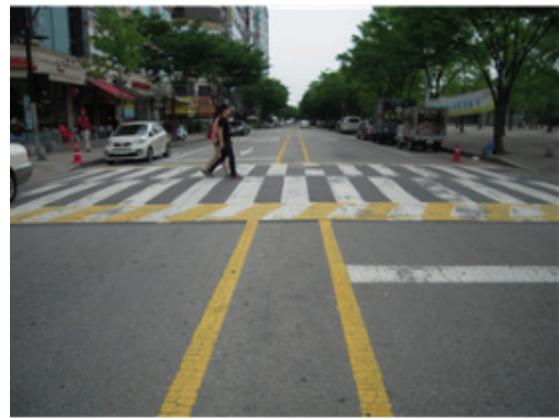
〈그림 3-45〉 고원식 횡단보도 설치 개념도 및 사례 (Richard, Steven, 2000)
