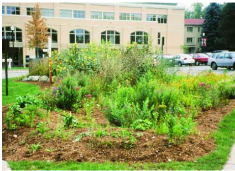
<그림 3.19> 빗물정원 설치 예
