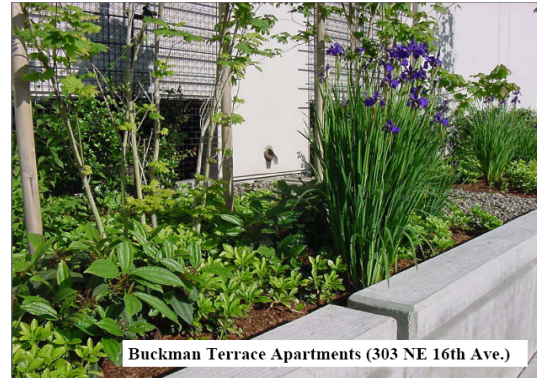
<그림 3.22> 통로화분 설치 예(City of Portland, 2004)
