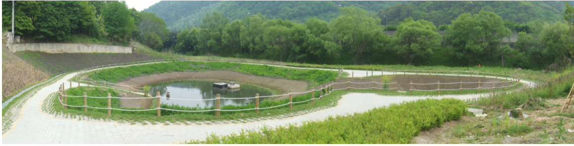
<그림 3.17> 침투저류지 설치 예
