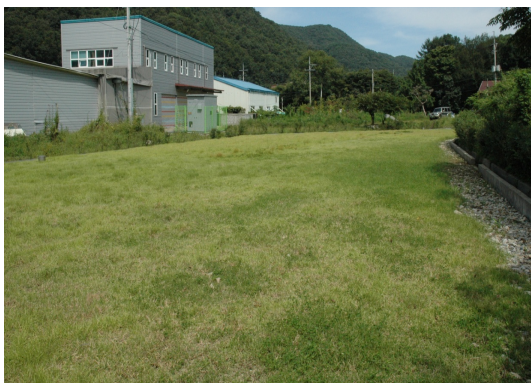
<그림 3.28> 식생여과대 설치 예
