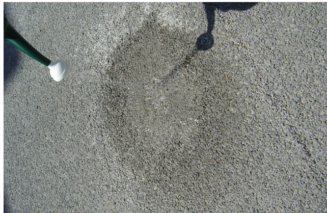
<그림 3.8> 투수성 콘크리트 설치 예
