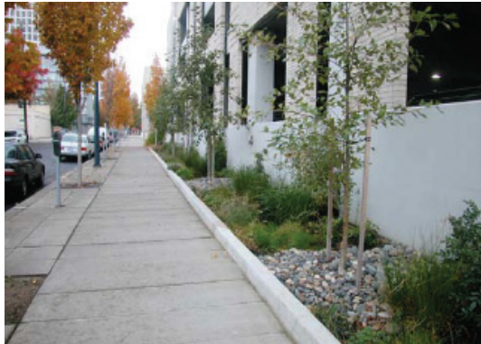
<그림 3.22> 통로화분 설치 예(City of Portland, 2004)
