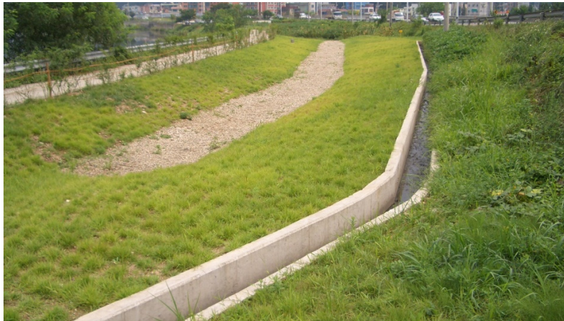
<그림 3.15> 침투도랑 설치 예
