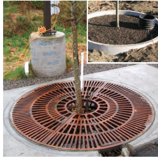
<그림 3.24> 수목여과박스 설치 예
