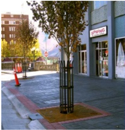
<그림 3.24> 수목여과박스 설치 예
