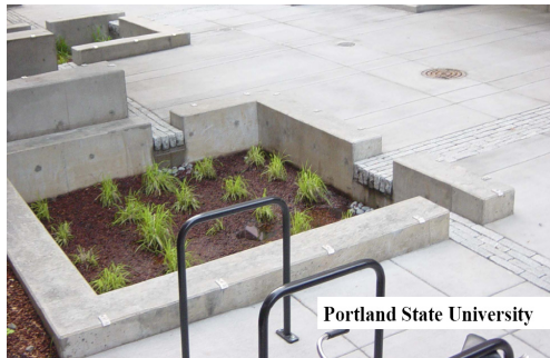
<그림 3.13> 침투화분 설치 예
