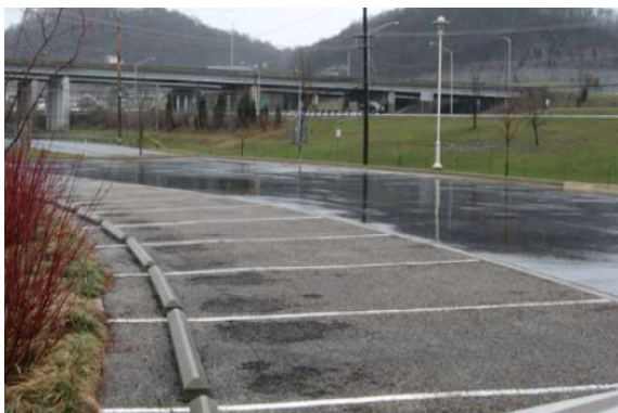
<그림 3.9> 투수성 아스팔트 설치 예
