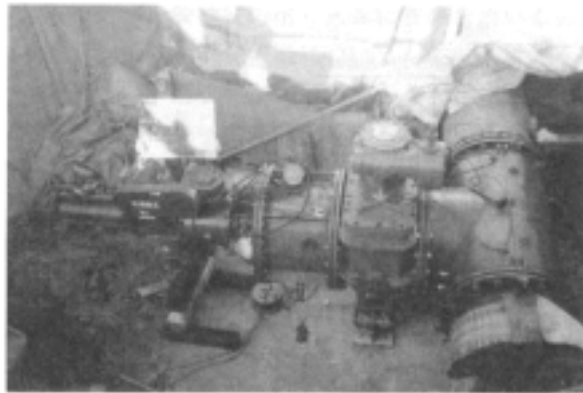
<그림-7.4.9> 무단수분기 및 밸브 설치의 예
