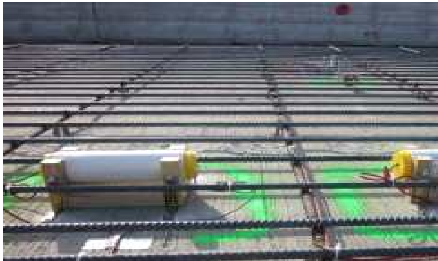
〈그림 7.13〉 PNC(Permeable Non Stress Cylinder)와 INC(Impermeable Non Stress Cylinder)
