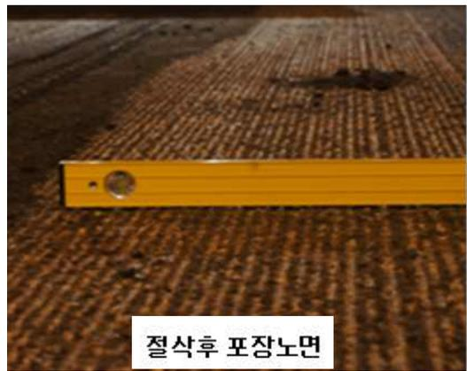
〈그림 2.7〉 15mm 비트 간격 드럼을 이용한 절삭 후 포장노면
