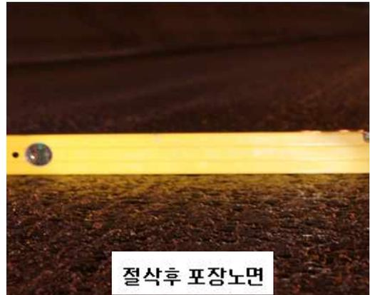
〈그림 2.8〉 8mm 비트 간격 드럼을 이용한 절삭 후 포장노면
