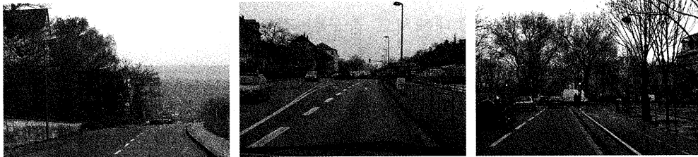
〈그림 6-9〉 일반도로 및 시가지 도로에서의 길어깨 생략
