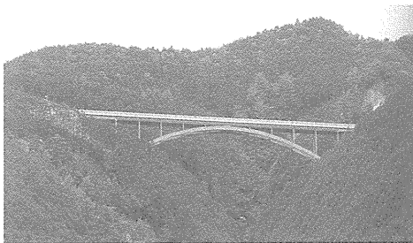
(a) 주변 경관과 조화를 이루며 생태축을 확보한 교량
