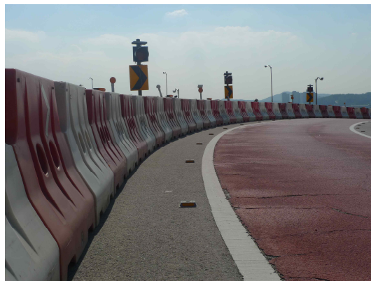
<그림 5.9> PE 울타리 설치 예
