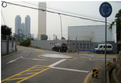
〈그림 4-9〉 초소형 회전교차로 국내 설치 사례
