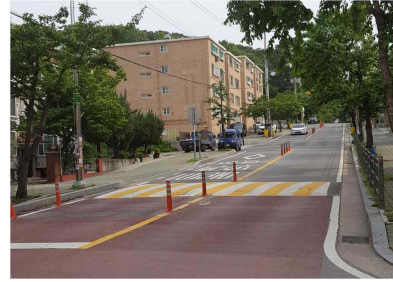
<그림 4-11> 과속방지턱 설치 개념도 및 사례
