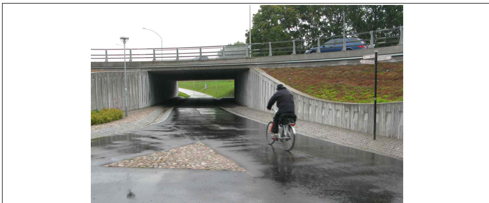
<그림 4.38> 입체 횡단보도 설치 예
