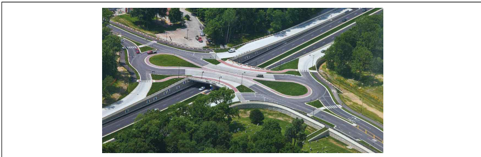
<그림 2.11> 물방울(T-Drop)형 회전교차로
