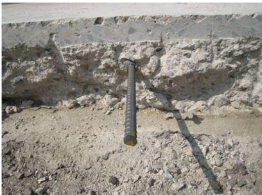
⑤ 타이바 설치
