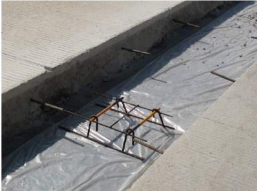
⑦ 다우웰바 설치
