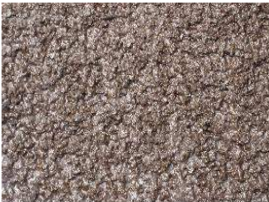
⑥ 마이크로 서페이싱 시공 후 모습
