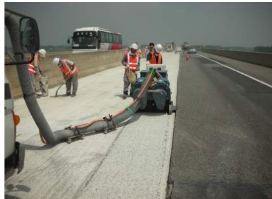
스� 블라스팅 작업
