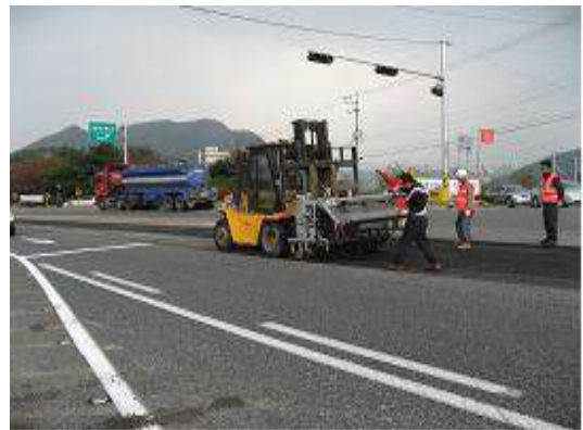
⑤ 그리드 설치
