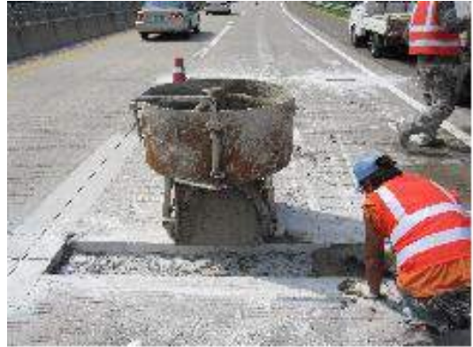
② 콘크리트 채우기
