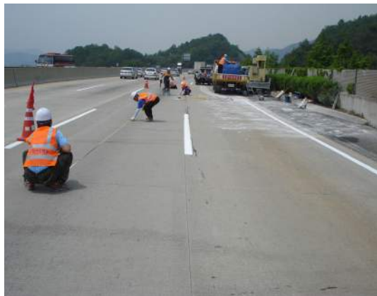
(a) 처짐량 측정
