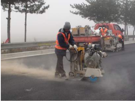
① 균열 부위 절삭
