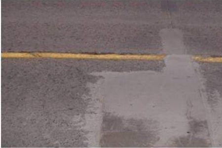
① 기존 콘크리트 보수
