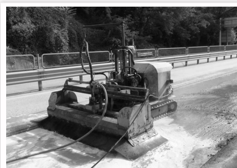
콘크리트 절삭 장비(water-jet)
