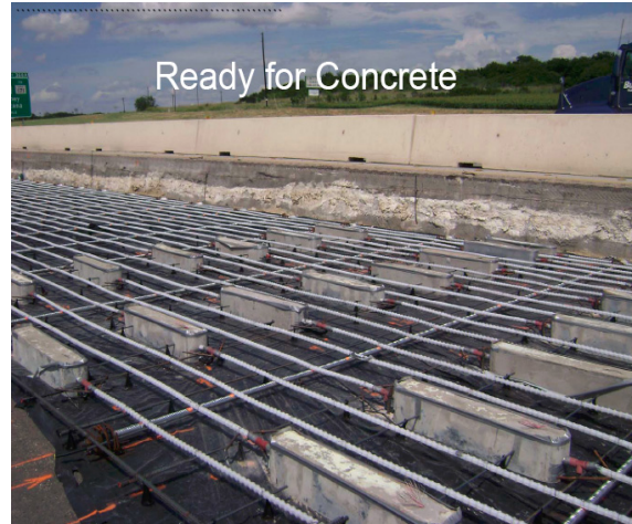
(b) 포스트 텐션 콘크리트 포장 시공
