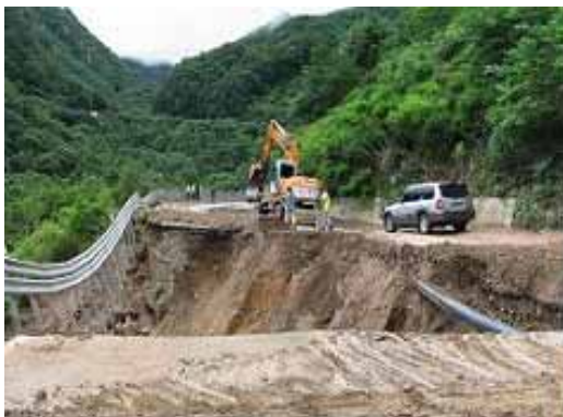
〈그림 2.2.6〉 쌓기 비탈면 유실 및 노면수 유입 피해 사례
