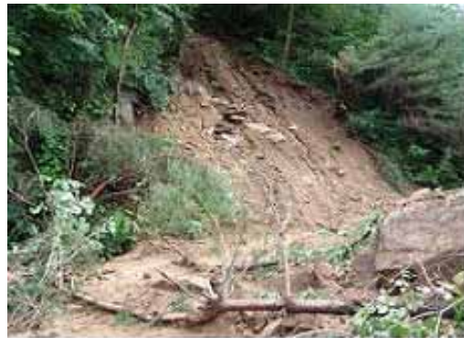
〈그림 2.2.5〉 깎기 비탈면의 낙석 및 표층 유실 피해 사례
