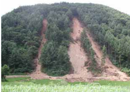
〈그림 2.2.5〉 깎기 비탈면의 낙석 및 표층 유실 피해 사례
