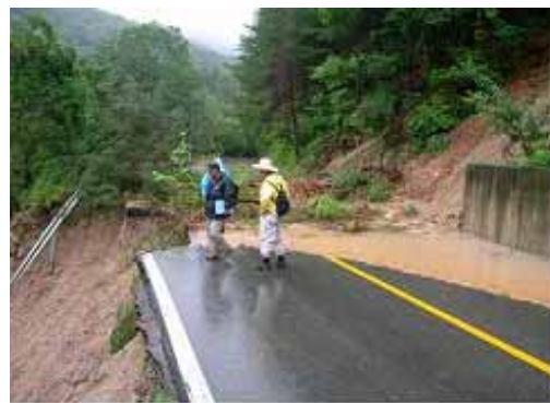
〈그림 2.2.6〉 쌓기 비탈면 유실 및 노면수 유입 피해 사례
