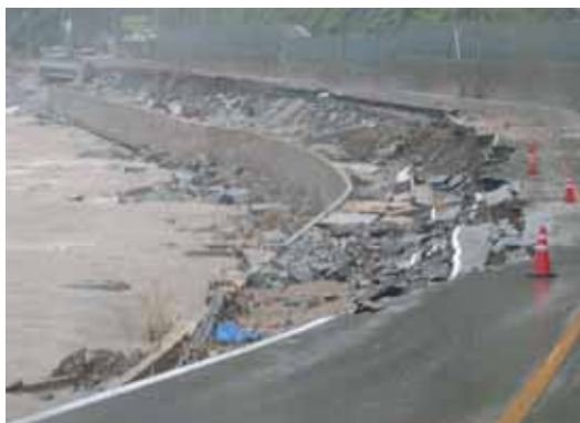
〈그림 2.2.2〉 산지하천 인접 도로 침식과 유실 피해 사례
