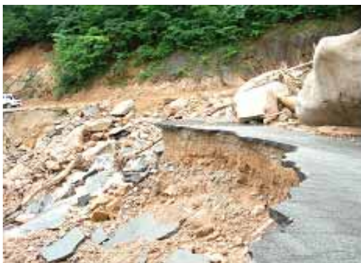
〈그림 2.2.1〉 토석류 및 부유목 등에 의한 도로 피해 사례
