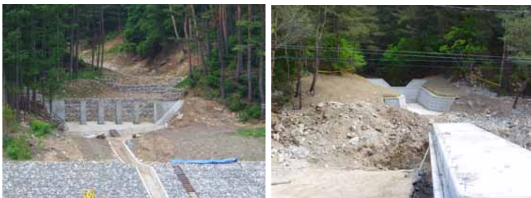
〈그림 5.3.6〉 토석류 차단 시설과 횡단배수암거의 연계 처리 사례
