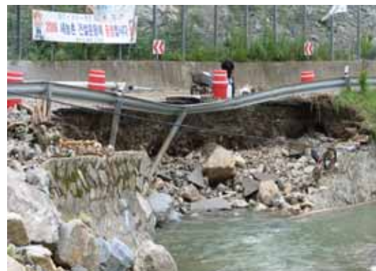
〈그림 2.2.2〉 산지하천 인접 도로 침식과 유실 피해 사례
