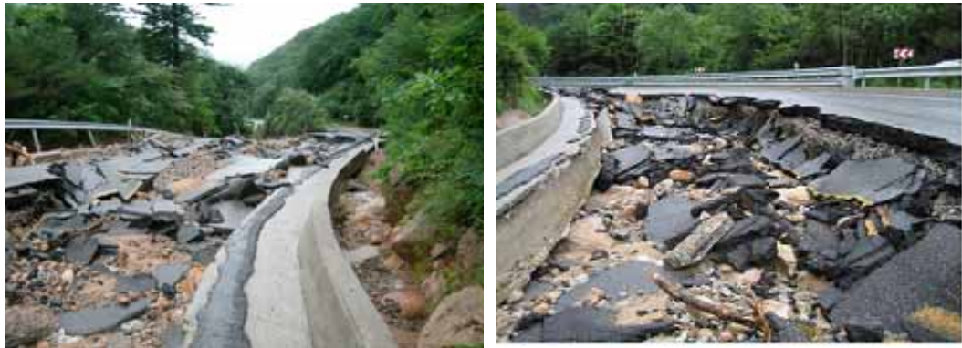
〈그림 2.2.7〉 산악 도로 하부 지반 침식에 의한 포장 피해 사례
