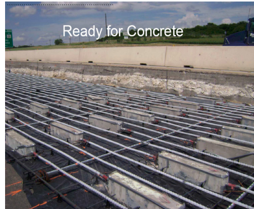
(b) 포스트 텐션 콘크리트 포장 시공
