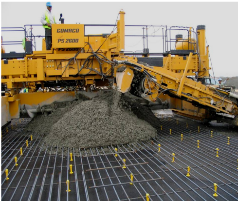
(a) 연속철근 콘크리트 포장 시공
