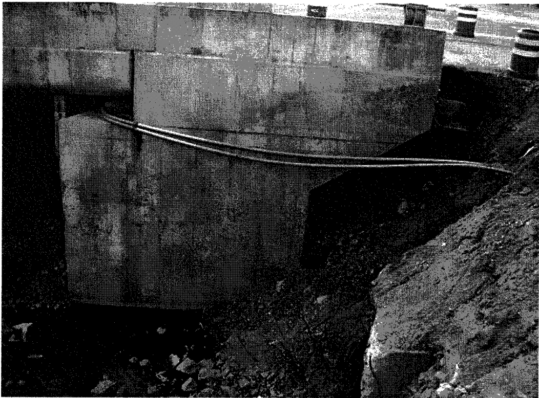
[사진-3] 성산1교 교대2 전경
