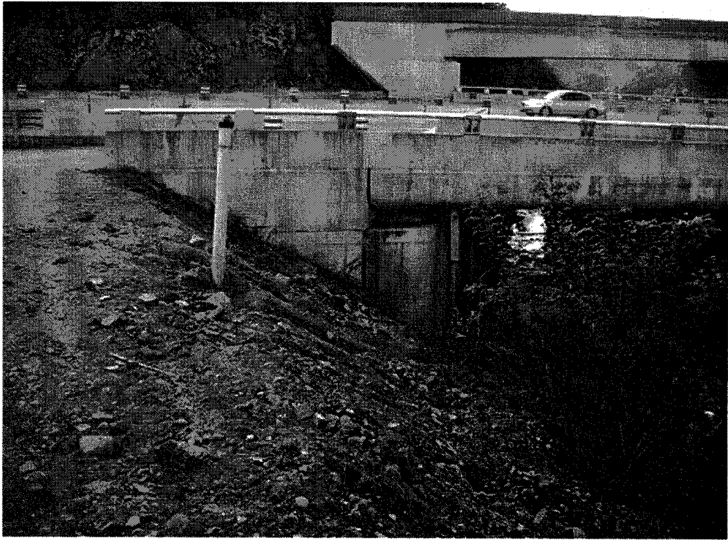
[사진-2] 성산1교 교대1 전경
