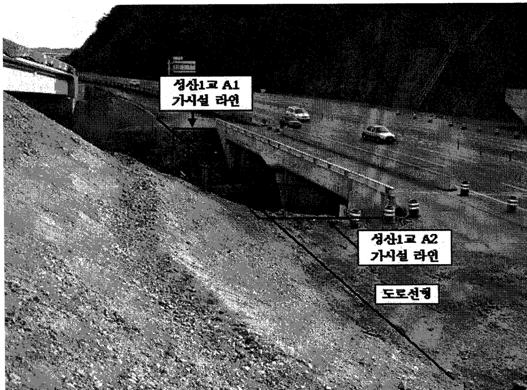
[사진-1] 성산1교 교대 가시설 설치위치
