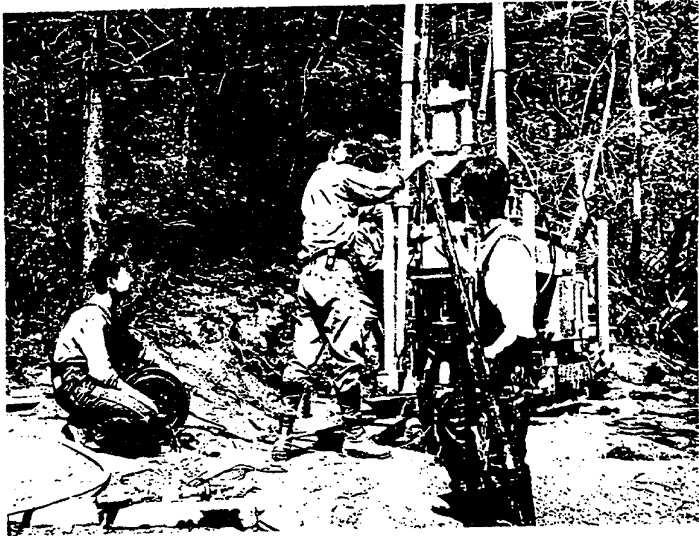
그림 3-5 스트래들 패카에 시추파이프를 연결하여 시추공내로 투입하는 모습
