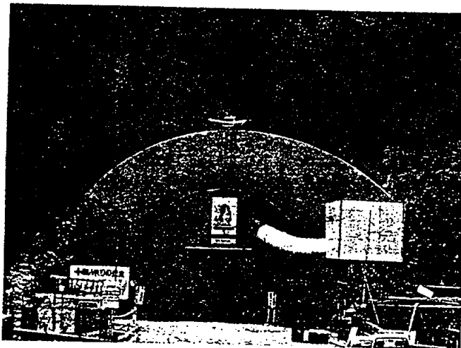
터널坑口에 設置한 모래채움식 防音壁
