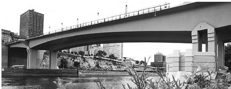
〈그림 4.4〉 교량 주변 공간과 잘 어울리는 교각
