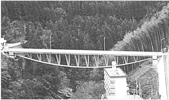
〈그림 7.13〉 상로식 적상판 구조 단면 예
