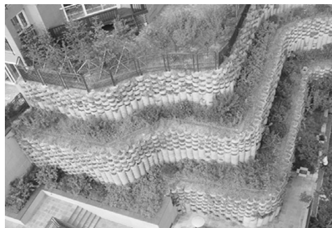
〈그림 4.4〉 식생옹벽을 이용한 방음벽 설치
