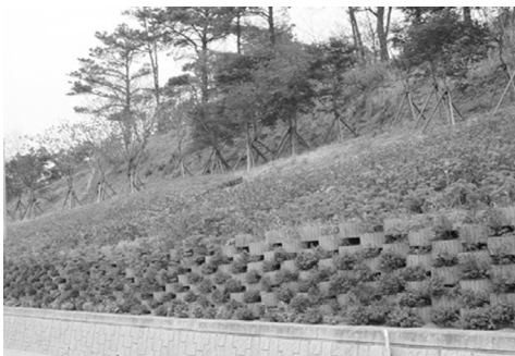
〈그림 4.4〉 식생옹벽을 이용한 방음벽 설치
