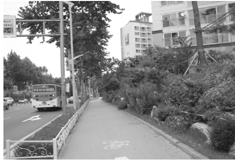
〈그림 4.3〉 토사 및 자연석을 이용한 방음벽 설치
