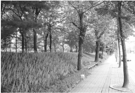
〈그림 4.3〉 토사 및 자연석을 이용한 방음벽 설치
