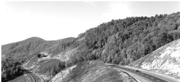
〈그림 5.2〉 지형을 이용한 방향별 선형 분리
