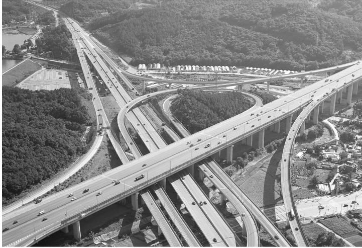
〈그림 2.25〉 지형훼손을 최소화한 나들목 설치
