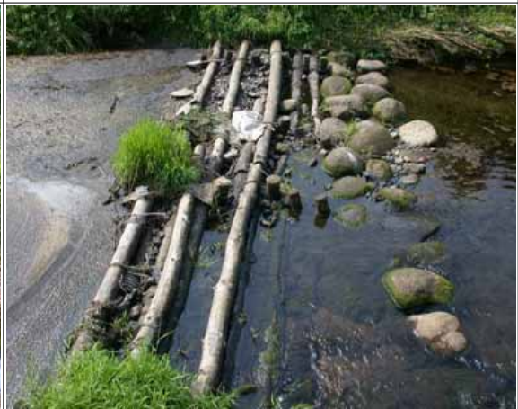
<사진 4> 여의천의 짚단여과장치
