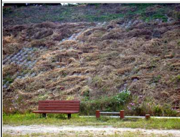
<사진 5> 안양천의 콘크리트제방
