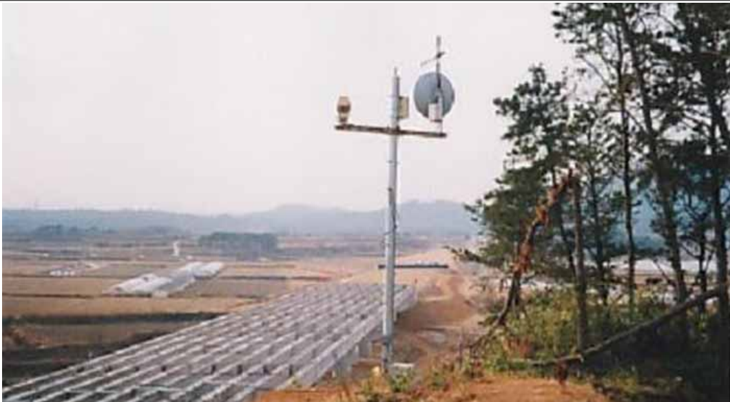
고창-담양 건설사업소 장성-담양간 제2공구
