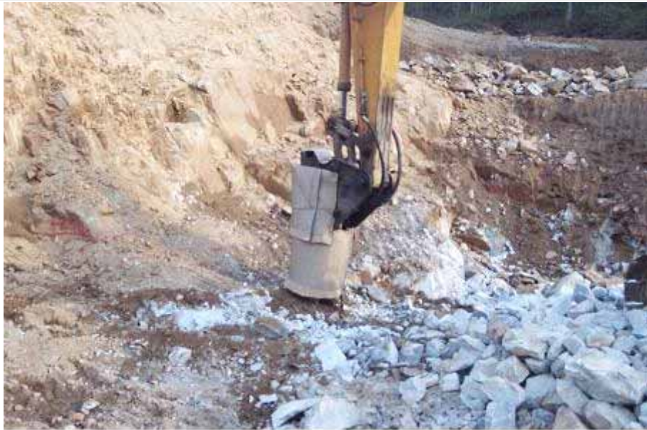
청원-상주간 고속도로 제4공구
