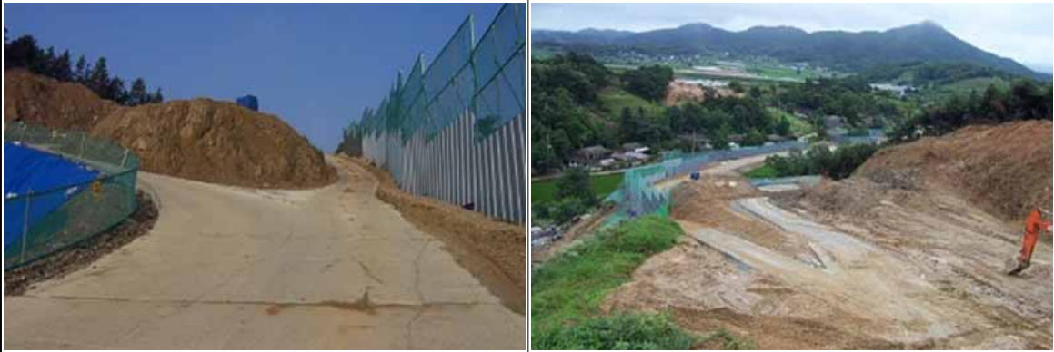
대전-당진 건설사업소 당진-대전간 제4공구
