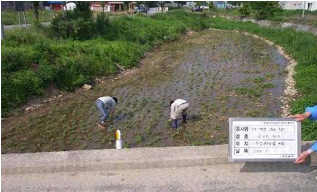
대전-당진건설사업소 당진-대전 제5공구
