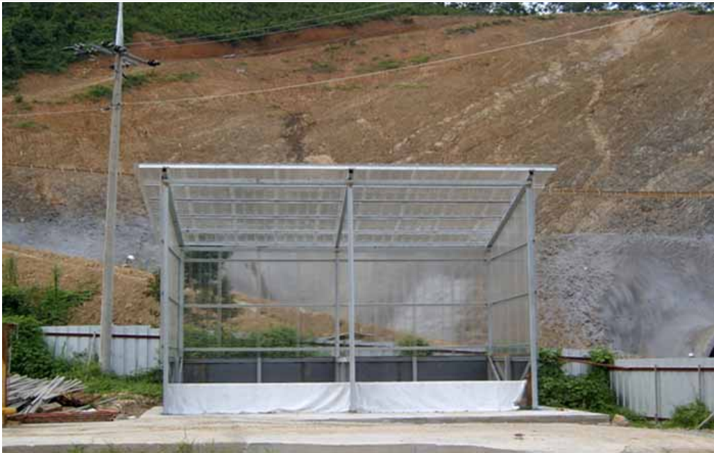
청원-상주간 고속도로 제8공구
