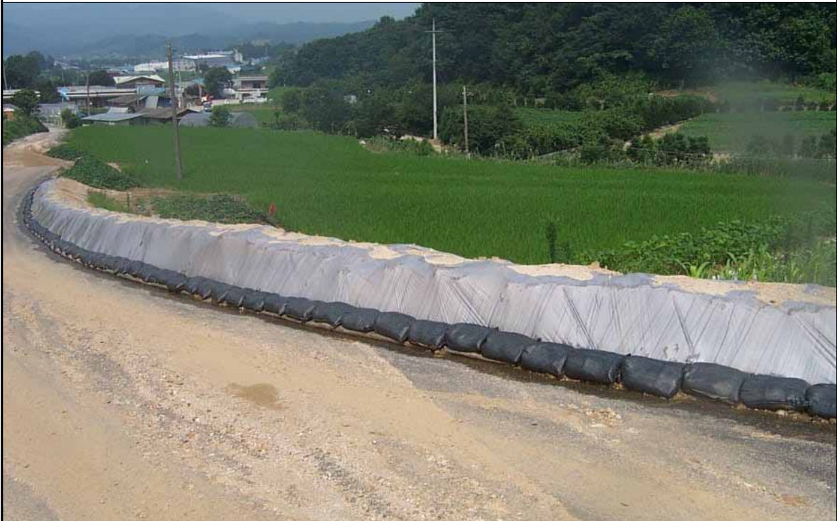
청원-상주간 고속도로 제1공구
