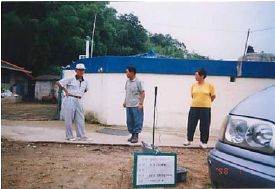
고창-담양 건설사업소 장성-담양간 제2공구
