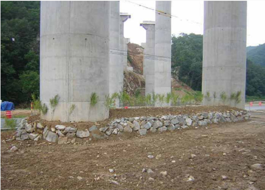
청원-상주간 고속도로 제7공구
