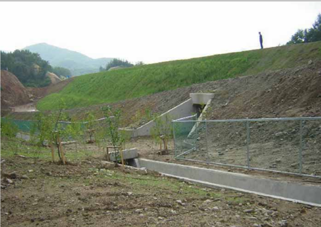
청원-상주간 고속도로 제7공구
