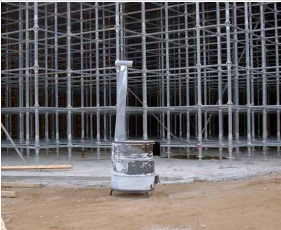
청원-상주간 고속도로 제5공구
