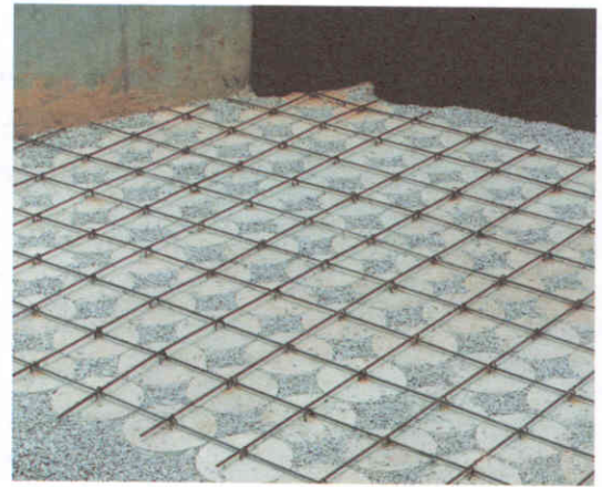
그림 4. 콘크리트 팽이형 말뚝기초 시공전경
