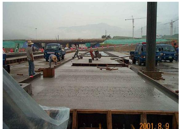
무근 콘크리트 적용 시험시공의 포설 및 먼마무리 전경
