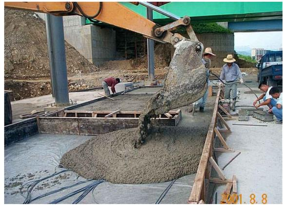
무근 콘크리트 적용 시험시공의 계측기 설치 부위 타설 전경
