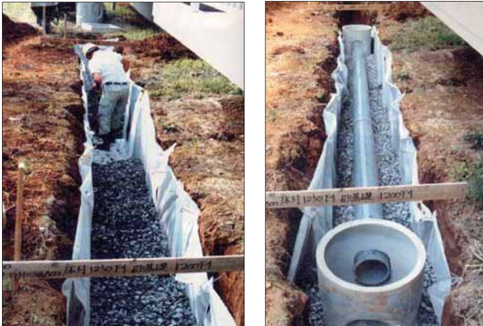
<그림 4-23> 침투통, 투수관을 설치하기 전 쇠석 충전 및 설치 모습
