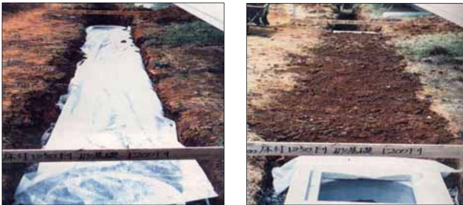
<그림 4-25> 투수시트의 매설 및 시공 완료 사진
