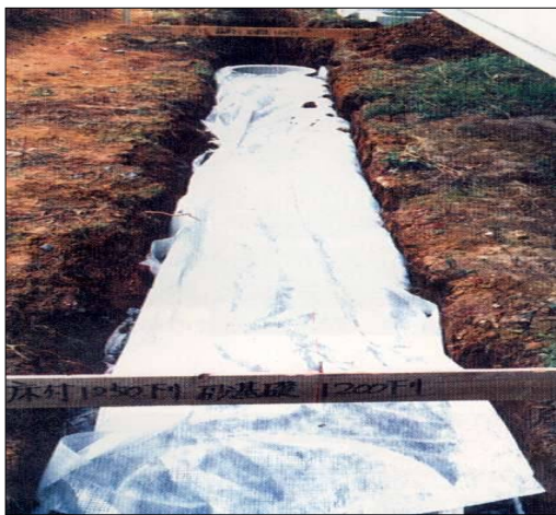
그림 4.25 투수시트의 매설 및 시공 완료 사진
