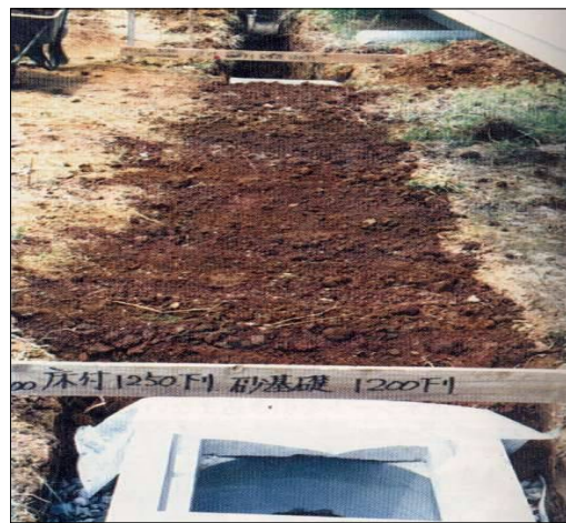
그림 4.25 투수시트의 매설 및 시공 완료 사진
