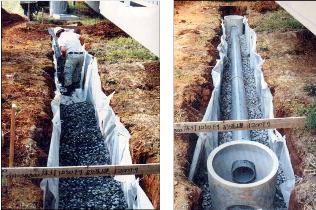
그림 4.23 침투통, 투수관을 설치하기 전 쇄석 충전 및 설치 모습
