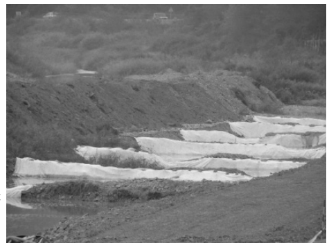
〈침사지 설치 전경〉
