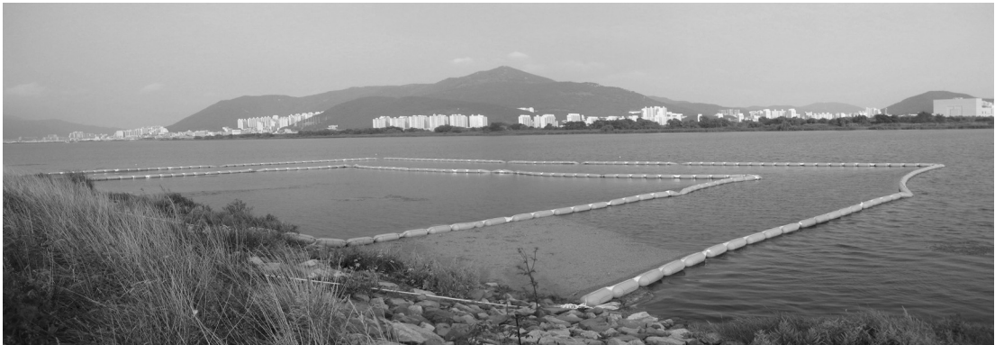
〈침사지에서 하천으로 유입시 오탉방지막 설치 전경〉
