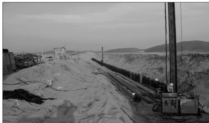
<그림 5.1-27> 널말뚝공법 시공 모습
