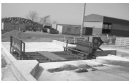
〈세륜시설 설치후 전경〉
