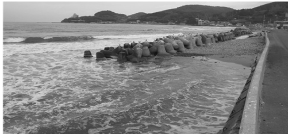
해설그림 (4.5-3) 호안 전면에 설치한 소파제 사례 (포항시 도구 해수욕장)
