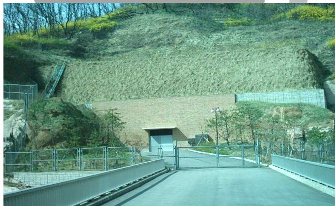
[그림 1.2.1] 터널식 배수지의 예(북악터널배수지)
