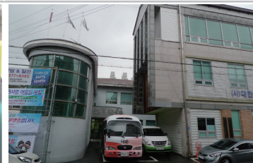
[X] 건물출입구 전면 주차장을 배치하여 보행자 사고의 위험성
