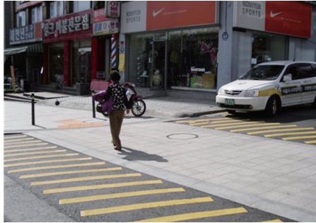
[O] 보행안전을 고려한 고원식횡단보도
