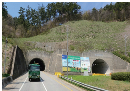
[X] 터널 진입부 기준 없이 설치된 입간판
