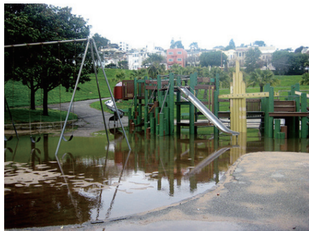
[X] 불량한 배수시설 및 노후화된 어린이 놀이 시설물
