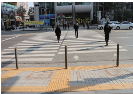
[X] 설치기준을 고려하지 않은 횡단보도 앞 시설물
