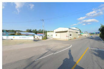
[사진 5-20] 도로변 창고시설
