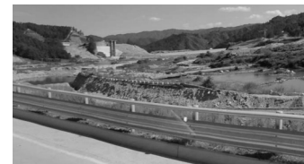
[사진 3-70] 부항댐 교량공사현장
