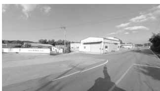
[사진 3-26] 도로변 창고시설
