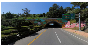
[사진 5-16] 직지저수지 앞 터널
