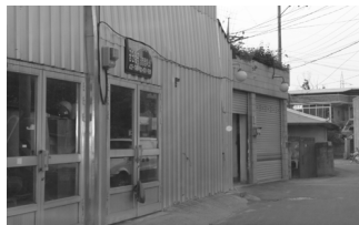
[사진 3-110] 삭막한 가로경관 형성
