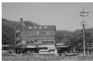
[사진 3-47] 주변과 조화롭지 못한 건축물
