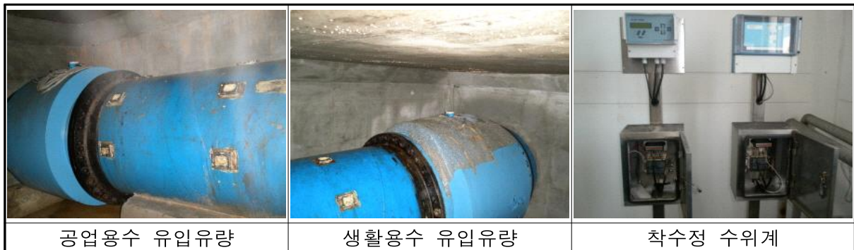
<그림 5.2-84> 현장 계측기기 사진(착수 및 혼화설비)
