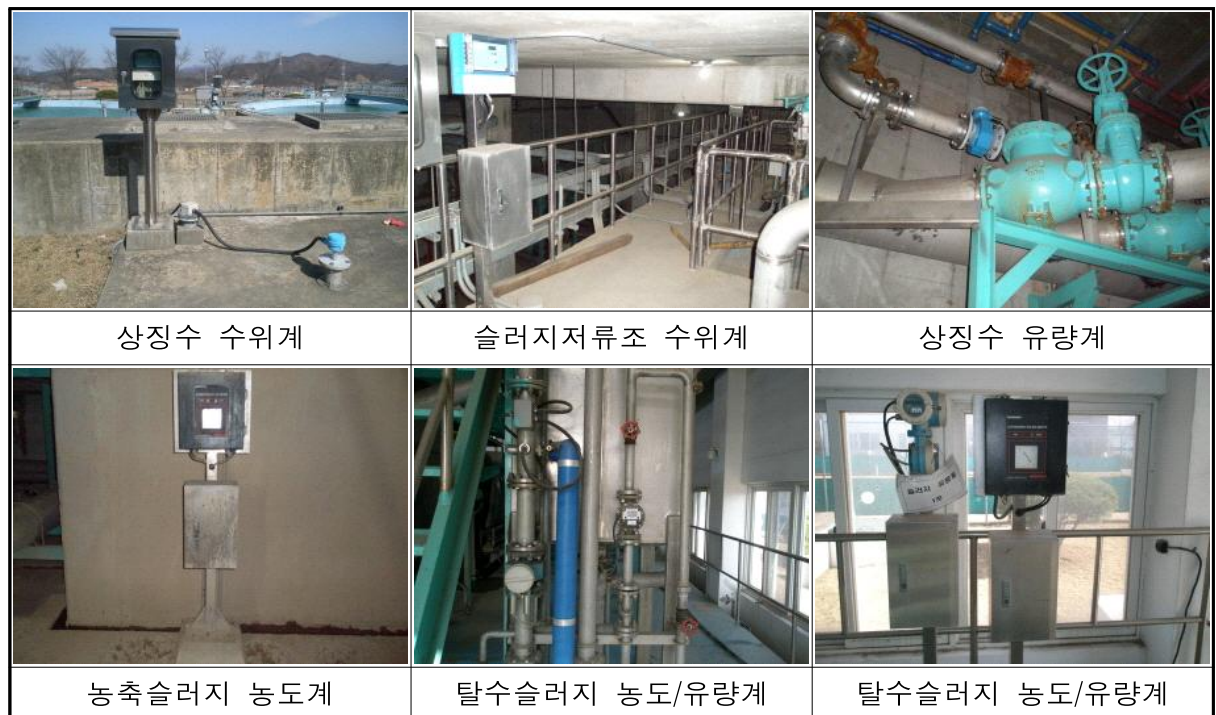
<그림 5.2-86> 현장 계측기기 사진(배출수 설비)
