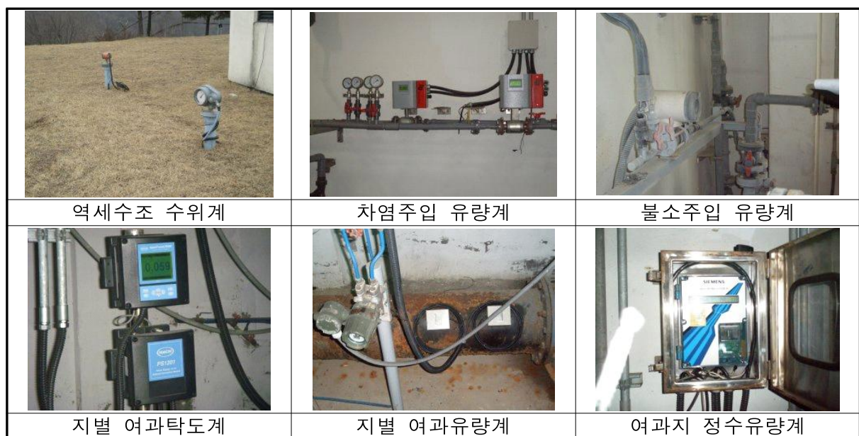
&lt;그림 5.2-76&gt; 현장 계측기기 사진(여과 및 정수설비)
