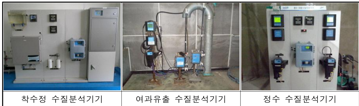
<그림 5.2-87> 현장 계측기기 사진(수질분석기기)
