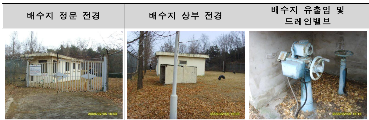
<그림 5.4-23> 배수지 설치현황
