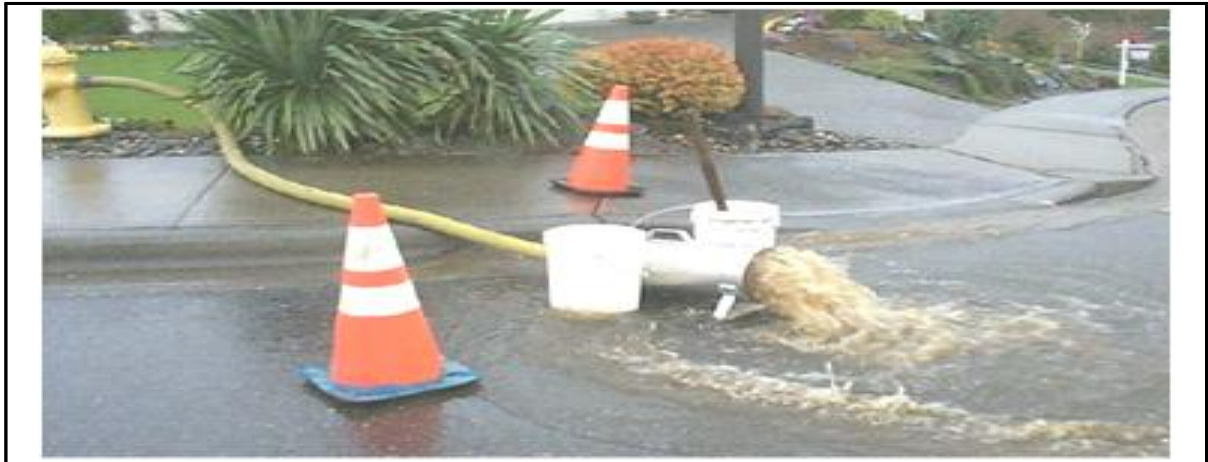
<그림 5.4-122> 소화전을 이용한 Flushing 기법
