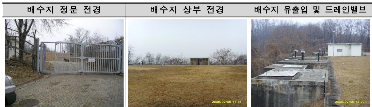
<그림 5.4-14> 배수지 설치현황
