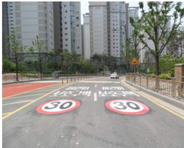
[그림 4.10] 속도제한 노면표시(어린이보호구역안) 시공사례
