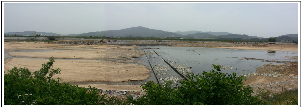
< 다단형 낙차공 설치 전경 (감천) >
