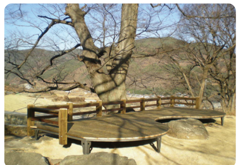
〈시공 전〉 방치된 공한지를 정리하고 돌흙막이를 설치하여 공간확보 및 경관을 개선하고, 목재데크를 시설한 다음 마사토를 포설
